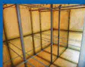
漏水修理 (FRPライニング)
