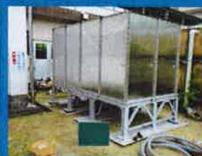
仮設16tステンレス水槽
