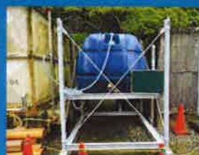
仮設2tポリタンク
